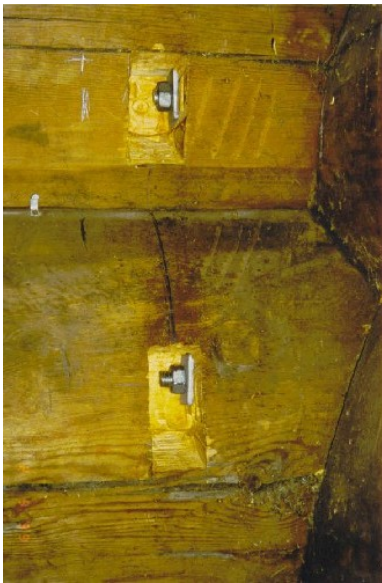
Photo 2.7: A gjengestag tightened together, Bakken, Bjørgum, Hylestad.
