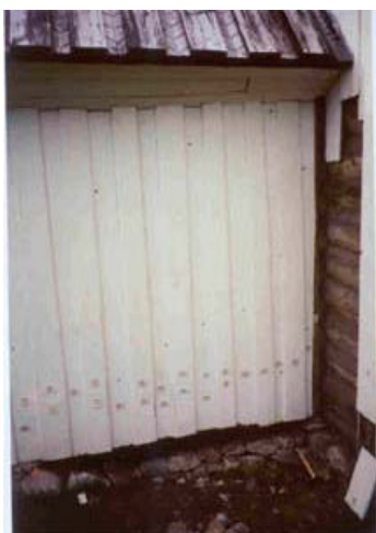
7. Våpenhuset: Vegg II Skrapa og måla.
