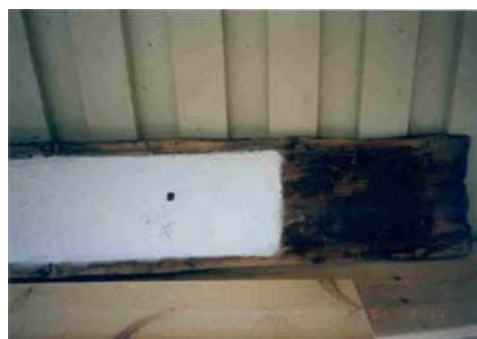
34. Koret: Vegg YC. Foto viser eitt underbord, festa med trenagler.
