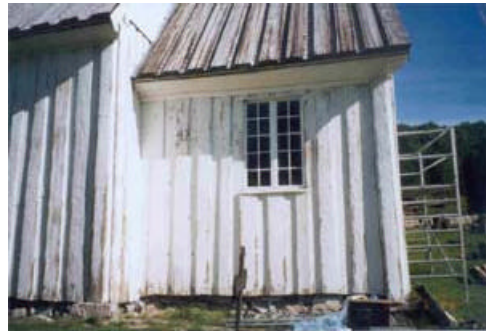
27 og 28. Koret: Vegg VI. Demontera muren for kontroll av tvifarane og tile. Tvifarane låg i tørr myrjord med små råteskada. Retta opp fundamenta til tvifarane. Remura grunnmuren på kult. Skrapa og måla.
