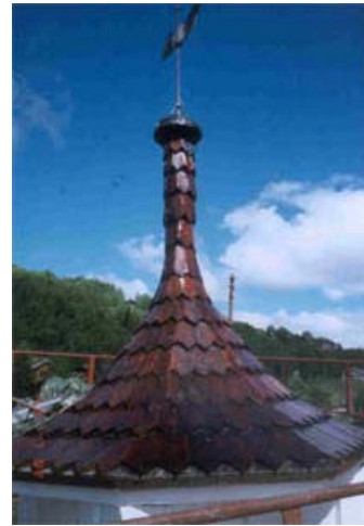
49. Spiret: Tjæra vart levera av Fortidsminneforeningen. Tjæra vart oppvarma i vassbad før bruk. Spiret vart tjæra med 4 strøk.
