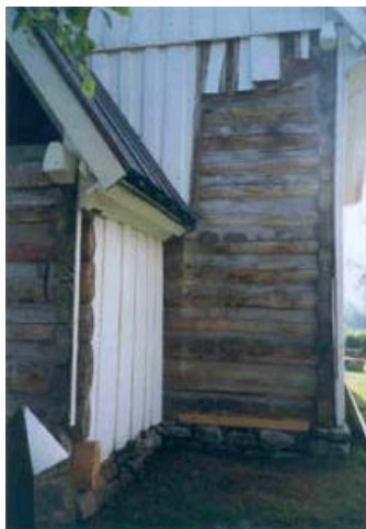
11. Skipet: Vegg III. Demontera utvnedning kledning.
