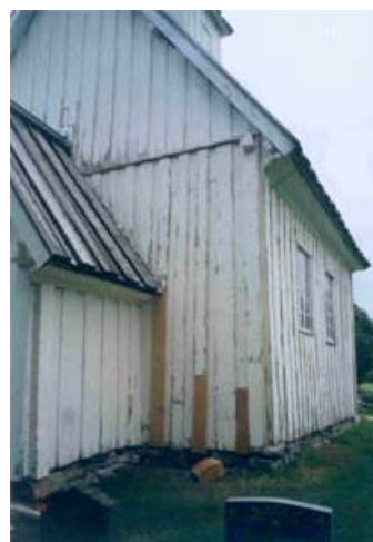
14. Skipet: Vegg III. Foto viser bruk av nytt virke. Skrapa og måla.
