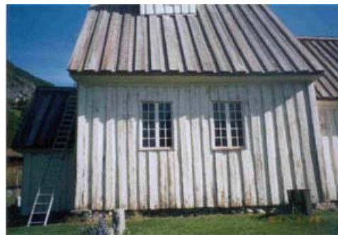
16. Skipet: Vegg III. Festa enkelte vegg bord og vassbord med handsmidde spiker. Skrapa og måla.
