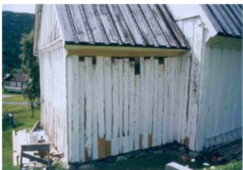
33. Koret: Vegg YC. Foto viser bruk av nytt virke. Skrapa og måla.
