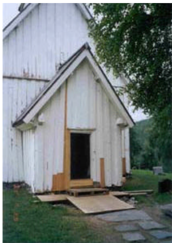
3. Våpenhuset: Montera utvendig kledning, foto viser bruk av nytt virke.
