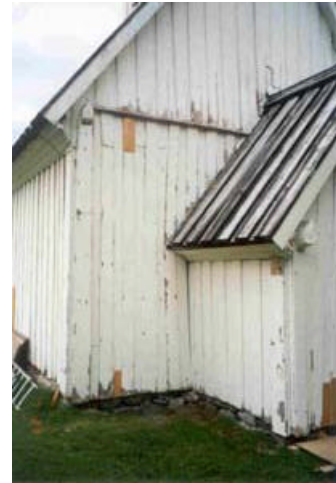
23. Skipet: Vegg CCC. Montera tilbake utvendig kledning. Foto viser bruk av nytt virke. Skrapa og måla.
