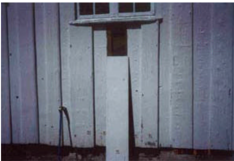
27 og 28. Koret: Vegg VI. Demontera muren for kontroll av tvifarane og tile. Tvifarane låg i tørr myrjord med små råteskada. Retta opp fundamenta til tvifarane. Remura grunnmuren på kult. Skrapa og måla.
