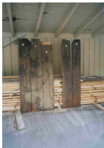
5. Våpenhuset: Foto viser 5 nye tileplanker, dei gamle var av nyare dato.
