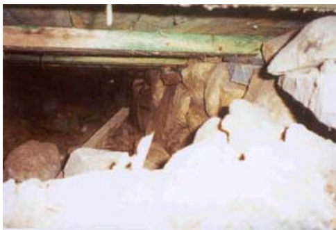
15. Skipet: Vegg III. Tvifarane var impregnerte med antiparasitt ved seiste restaurering.
