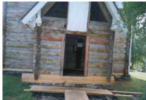
2. Våpenhuset: Rekonstruerte svilla og lafta den på plass.
